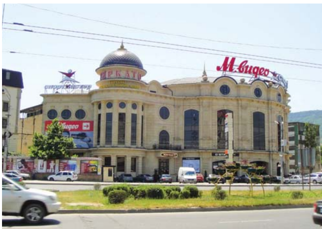
ТОРГОВЫЙ ЦЕНТР «МИРКАТО» Махачкала, 590 кВт
