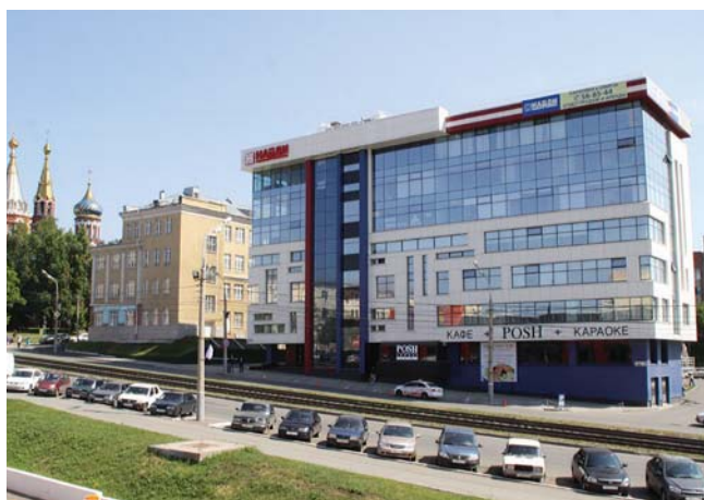
БИЗНЕС-ЦЕНТР «НАЙДИ» Ижевск, 498 кВт
