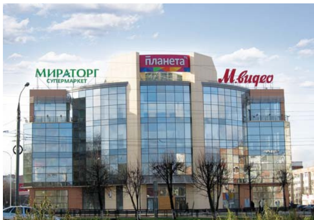
ТОРГОВЫЙ ЦЕНТР «ПЛАНЕТА» Йошкар-Ола, 836 квТ
