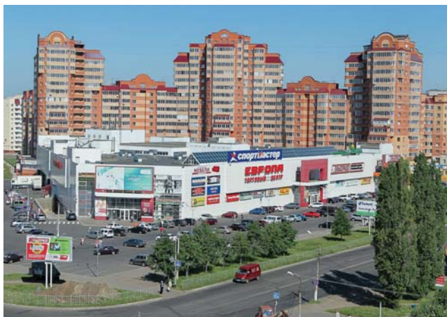
ТОРГОВЫЙ ЦЕНТР «ЕВРОПА 26» Железногорск, 320 кВт
