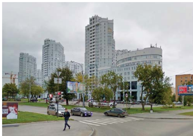
БИЗНЕС-ЦЕНТР «ТАТИЩЕВСКИЙ» Екатеринбург, 500 кВт
