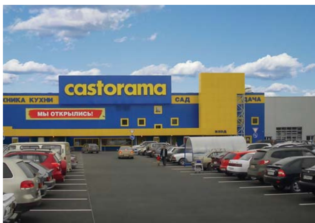
ГИПЕРМАРКЕТ СТРОИТЕЛЬНЫХ ТОВАРОВ «КАСТОРАМА» Уфа, 1 МВт
