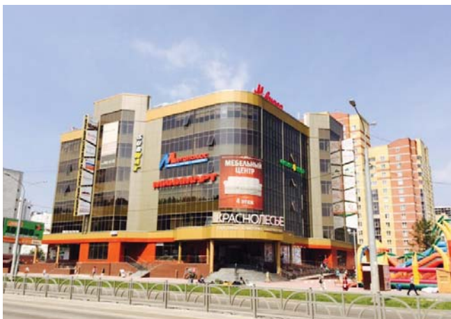
ТОРГОВЫЙ ЦЕНТР «КРАСНОЛЕСЬЕ» Екатеринбург, 700 кВт
