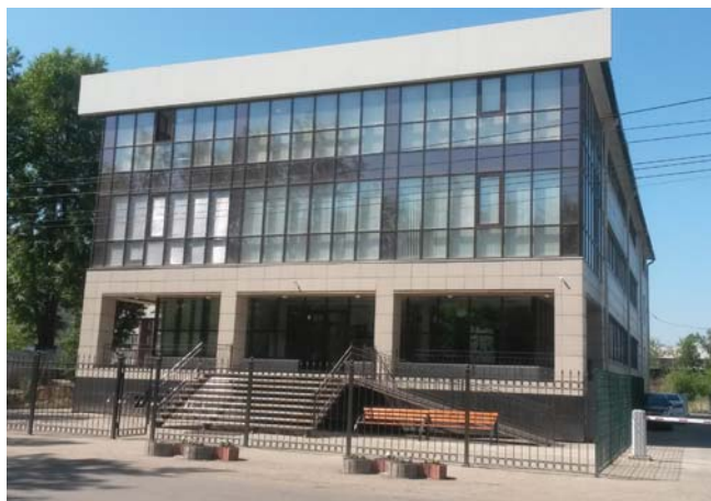
КОЛЛ-ЦЕНТР «ТЕЛЕ2» Иркутск, 300 кВт
