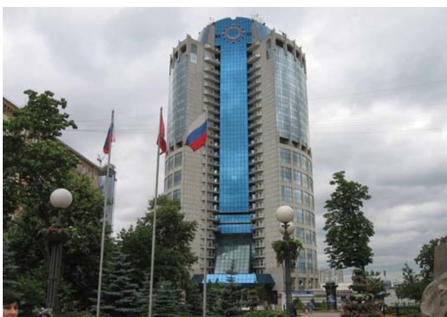
ГУП «МОСВОДОСТОК» Москва, 440 кВт
