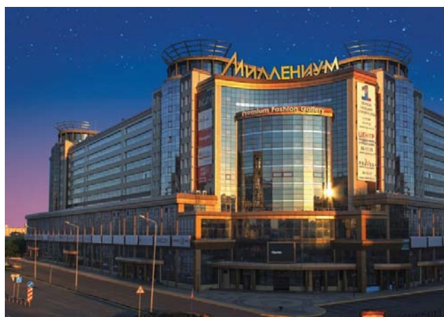
ТОРГОВЫЙ ЦЕНТР «МИЛЛЕНИУМ» Омск, 410 кВт
